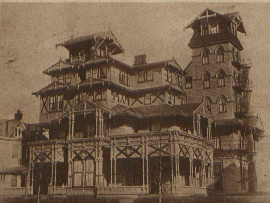
1) Ciekawy dom znajduje się w Atlantic City (St. Zjedn.) Zbudowany cały z twardego drzewa, spajany jest drewnianymi klamrami i nie zawiera w sobie ani jednego gwoźdźdź, ani jednej śrubki i wogóle żadnego metalu. Dom ten zbudowany został w r. 1876 i trzyma się znakomicie do dnia dzisiejszego. — 2) Olbrzymi pożar połączony z eksplozjami gazołiny wybuchł w kopalniach nafty w Massachusetts (St. Zjedn.) W ostatnich czasach w niektórych szybach, z niewyjaśnionych dotąd powodów, wybuchają takie pożary co kilka tygodni, wyrządzając szkody idące w setki tysięcy dolarów.
