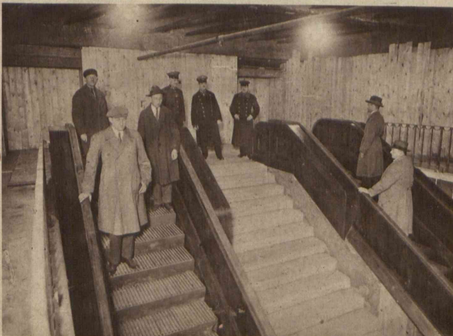
Na wzór amerykański urządzono obecnie w Berlinie na jednym z dworców kolei podziemnej schody ruchome. Na schodach tych wystarczy stanąć i wyjeżdża się do góry wzgl. na dół. W środku są rezerwowe schody normalne.
