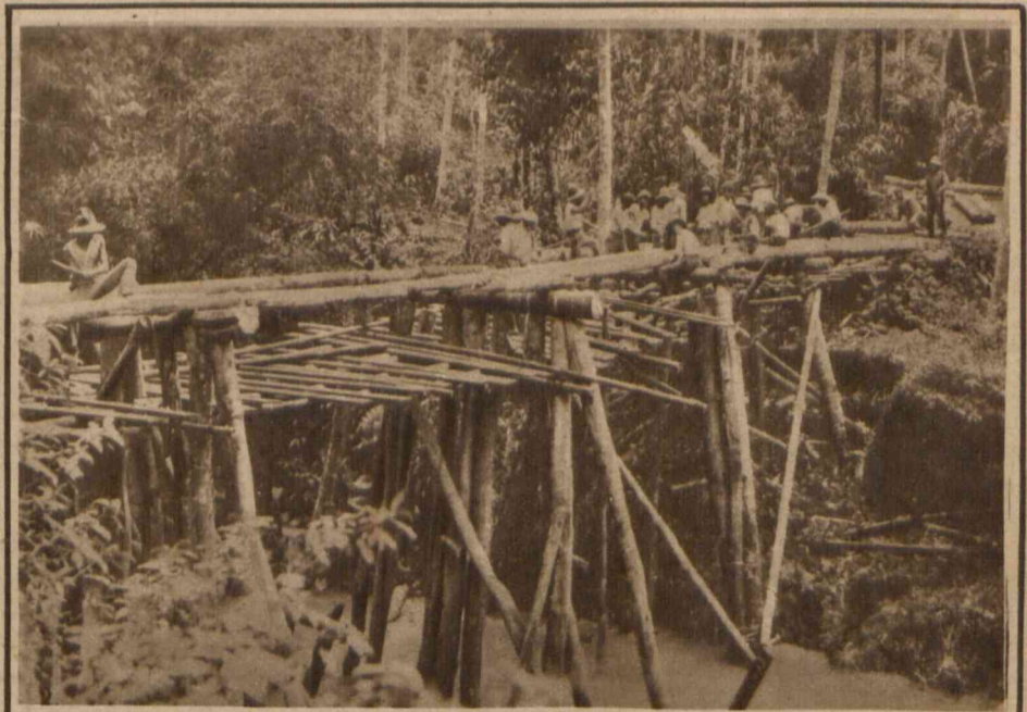
Uciążliwa budowa drogi w dżungli w Indjach niderlandzkich. Most, którego główną częścią składową są bambusy.
