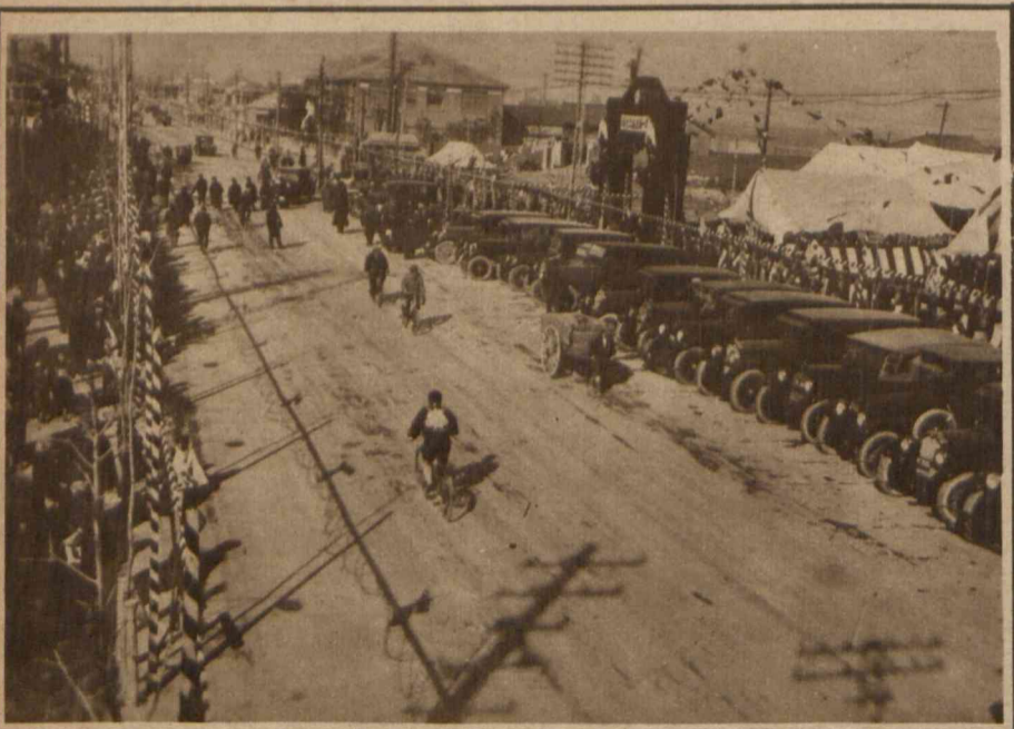
Otwarcie nowej drogi samochodowej z Tokio do Jakohamy. Jak widzimy egzotyczna Japonja buduje drogi, których możemy im pozazdrościć.
