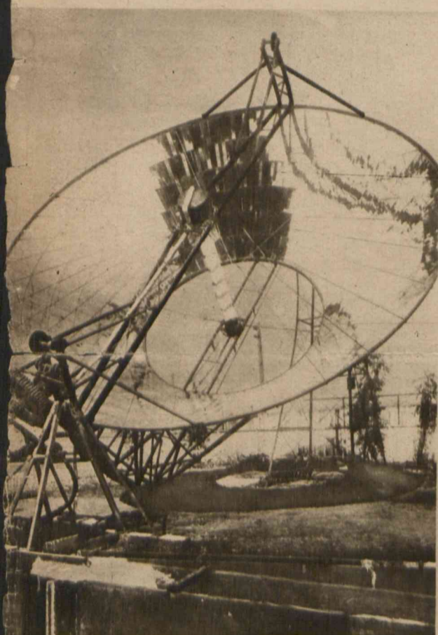
Maszyna parowa z cylindrem zawierającym 800 litrów wody, ogrzewanej przez słońce.
