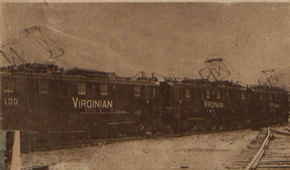
Stacja w Wirginji (St. Z.) jest obecnie zupełnie zelektryfikowana i posiada największe lokomotywy pociągowe i ciężarowe.
