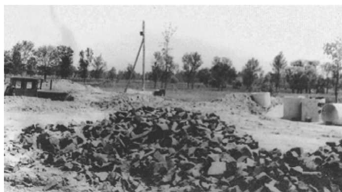
Будівництво дороги на місці замкненої річки. Фото Ігоря Шевченківського, 1950-і рр.
