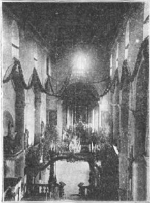
Wnętrze kościoła w Brochowie.
