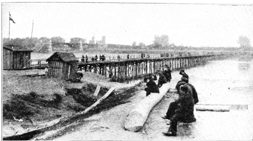
Most na palach obok III-go, łączący Warszawę z Pragą, wybudowany w ciągu 2-ch dni.
