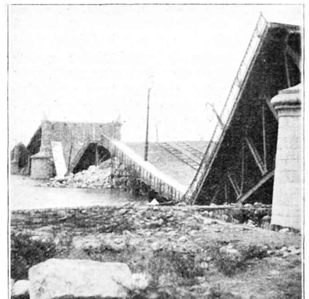
Most ks. Poniatowskiego od strony Pragi w Warszawie. Fot. S. Walczaka.
