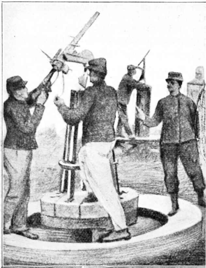
Francuska mitraljeza do ostrzeliwania lotników. Platforma ruchoma i kąt odchylenia może być w sekundę zmieniony.
