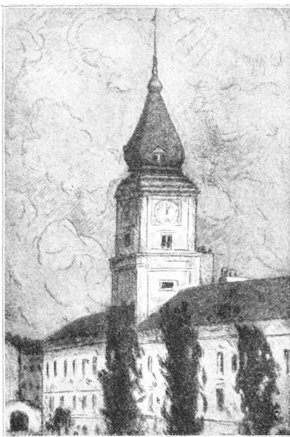
Naprawa zegara na wieży Zamku Królewskiego w Warszawie.
