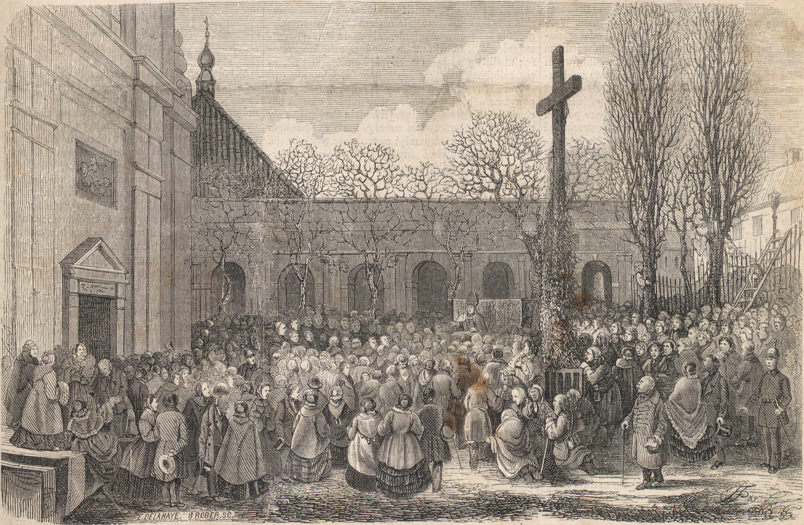
POGRZEBANIE KOŚCI NA DAWNYM CMENTARZU Ks. REFORMATÓW W WARSZAWIE.
