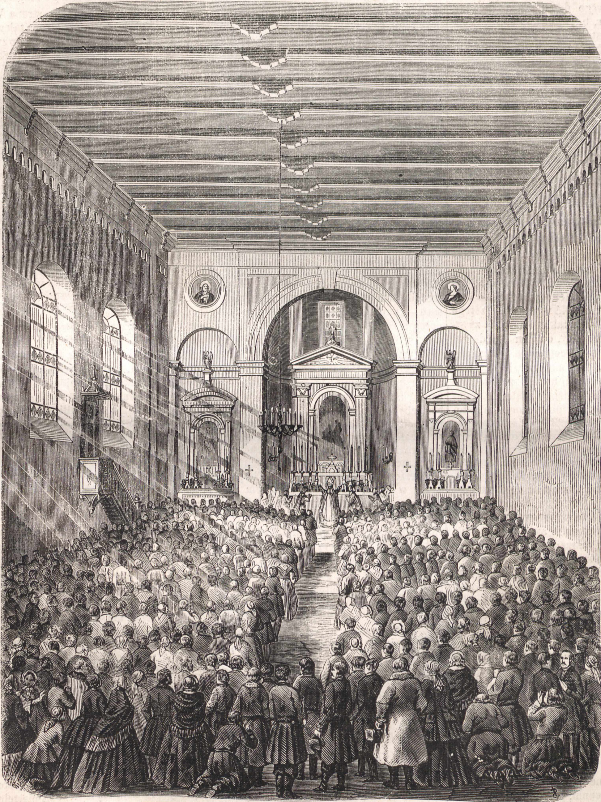
WNĘTRZE NOWEGO KOŚCIOŁA NA WOLI POD WARSZAWĄ.
