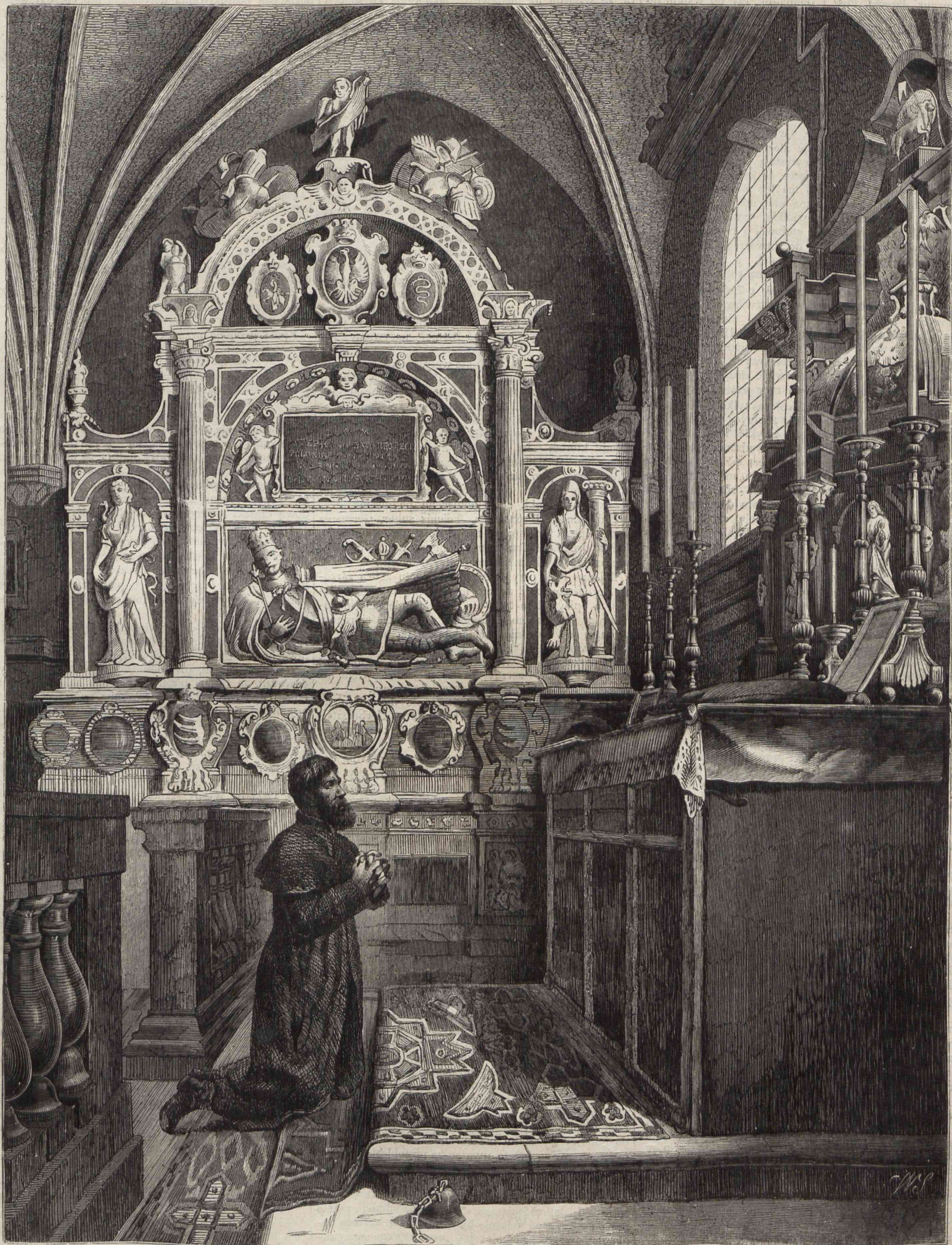
KAPLICA BATOREGO W KATEDRZE KRAKOWSKIEJ. (Rysował na miejscu Szerner).
