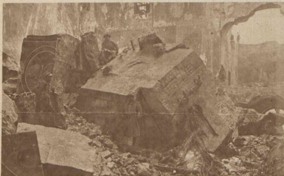
Dla przyspieszenia rozbiórki soboru na Placu Saskim, postanowiono przy pomocy materiałów wybuchowych zwalić 4 kolumny granitowe i tym sposobem podważyć sklepienie. Zdjęcie nasze przedstawia granitowe bryły sklepienia, zwalone wybuchem, leżące na wysokość paru pięter na posadzce soboru.
