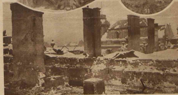
Dach gmachu sejmowego.
