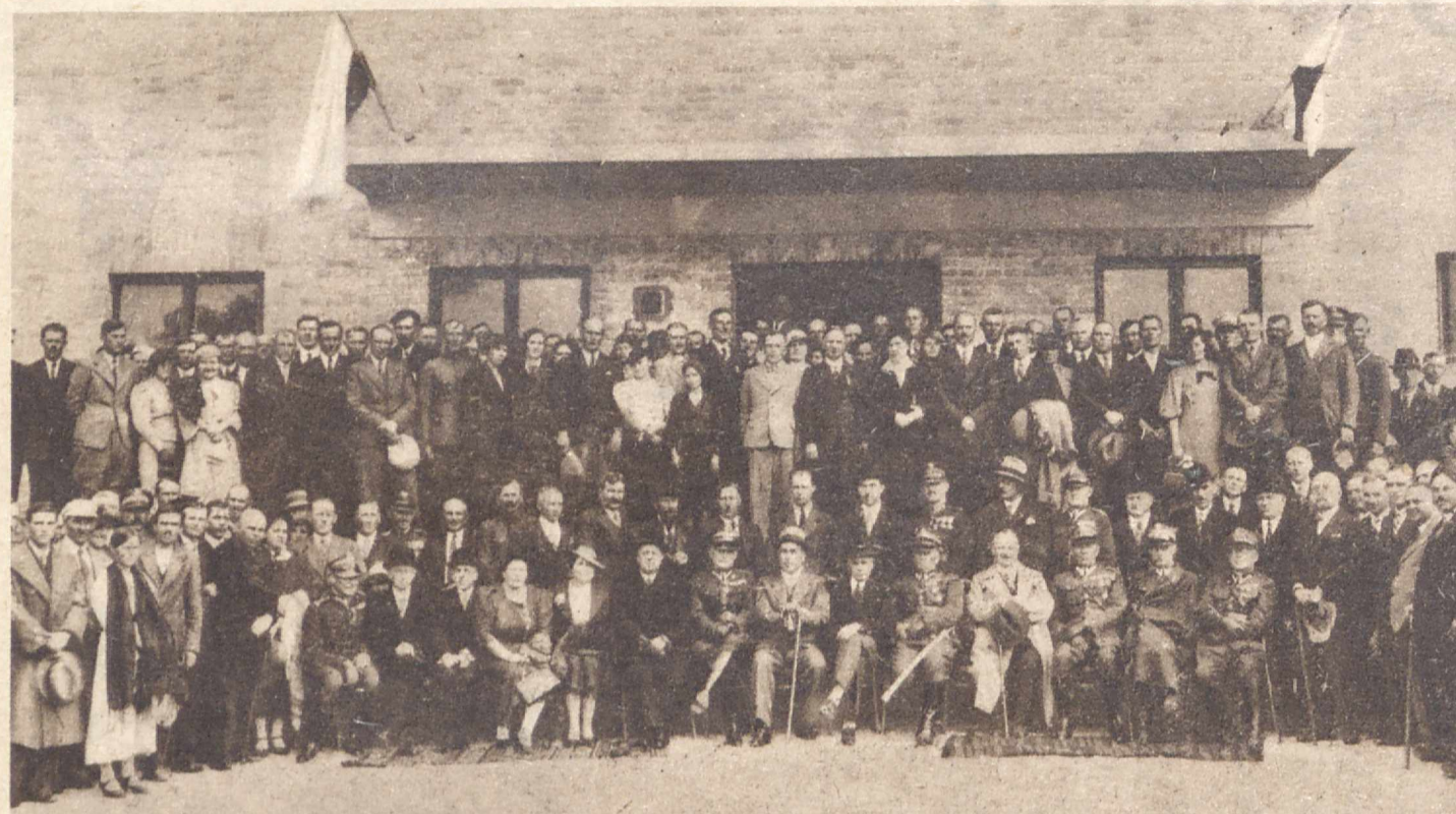
UROCZYSTOŚCI OSADNICZE W RÓWNEM. W obecności p. wojewody Józewskiego odbyło się w Równem poświęcenie nowego gmachu Gimnazjum i bursy dla dzieci osadników, oraz 4-piętrowego gmachu elewatora zbożowego, wyposażonego w najnowocześniejsze urządzenia. Na zdjęciu osadnicy powiatu rówieńskiego z siedzącymi w pierwszym rzędzie pp. woj. Józewskim, płk. Myszkowskim, star. Rogowskim i płk. Myrkiem.
