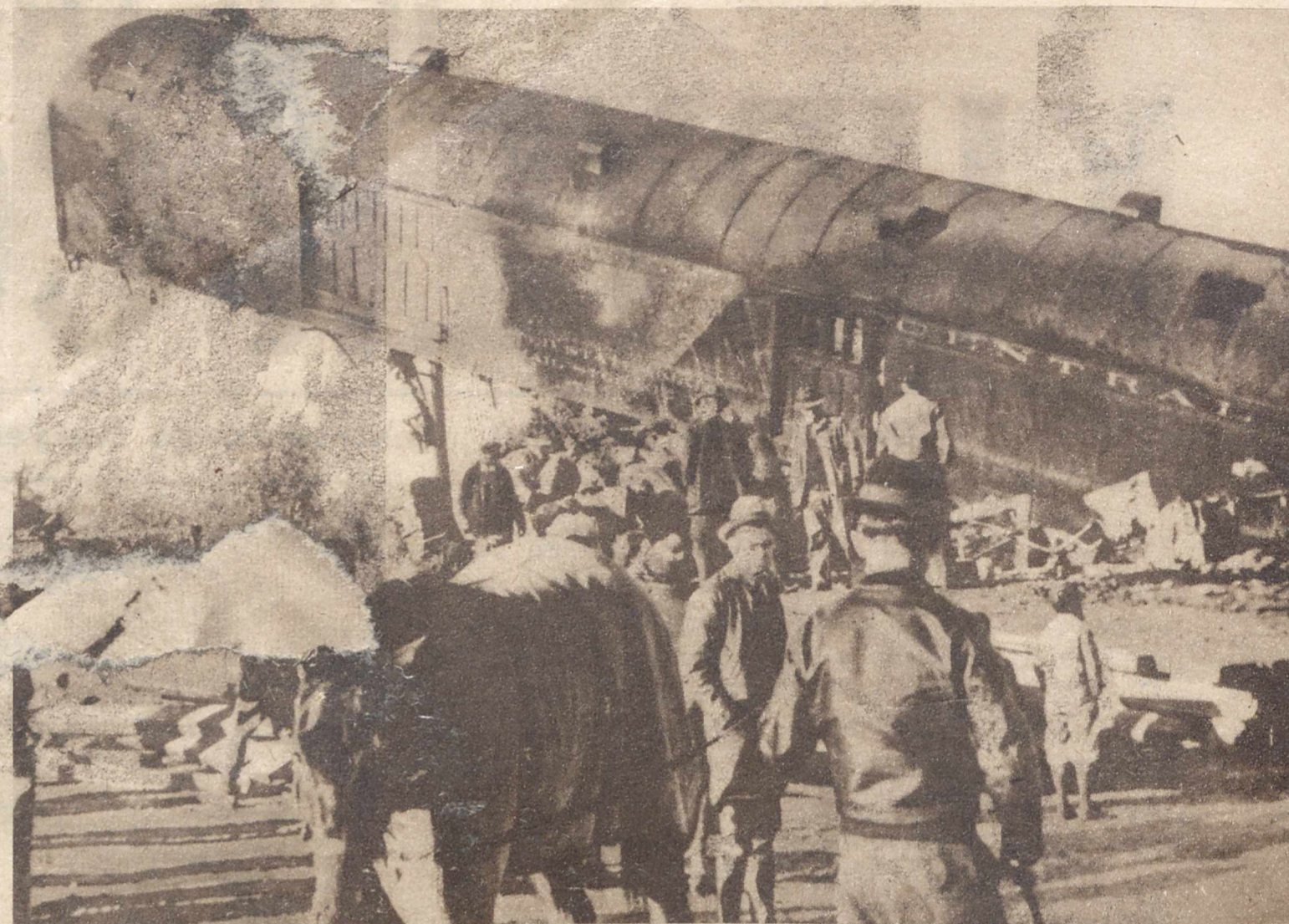
KROWA PRZYCZYNA KATASTROFY KOLEJOWEJ. Amerykański express, pędzący w kierunku miasta Illinois, uległ wykołaceniu skutkiem niezwyklego wypadku, najechawszy na przechodzącą torom krowę z cielęciem wykołecił się, przyczem skutkiem wykołecenia parowozu maszynista i palacz ponieśli śmierć.
