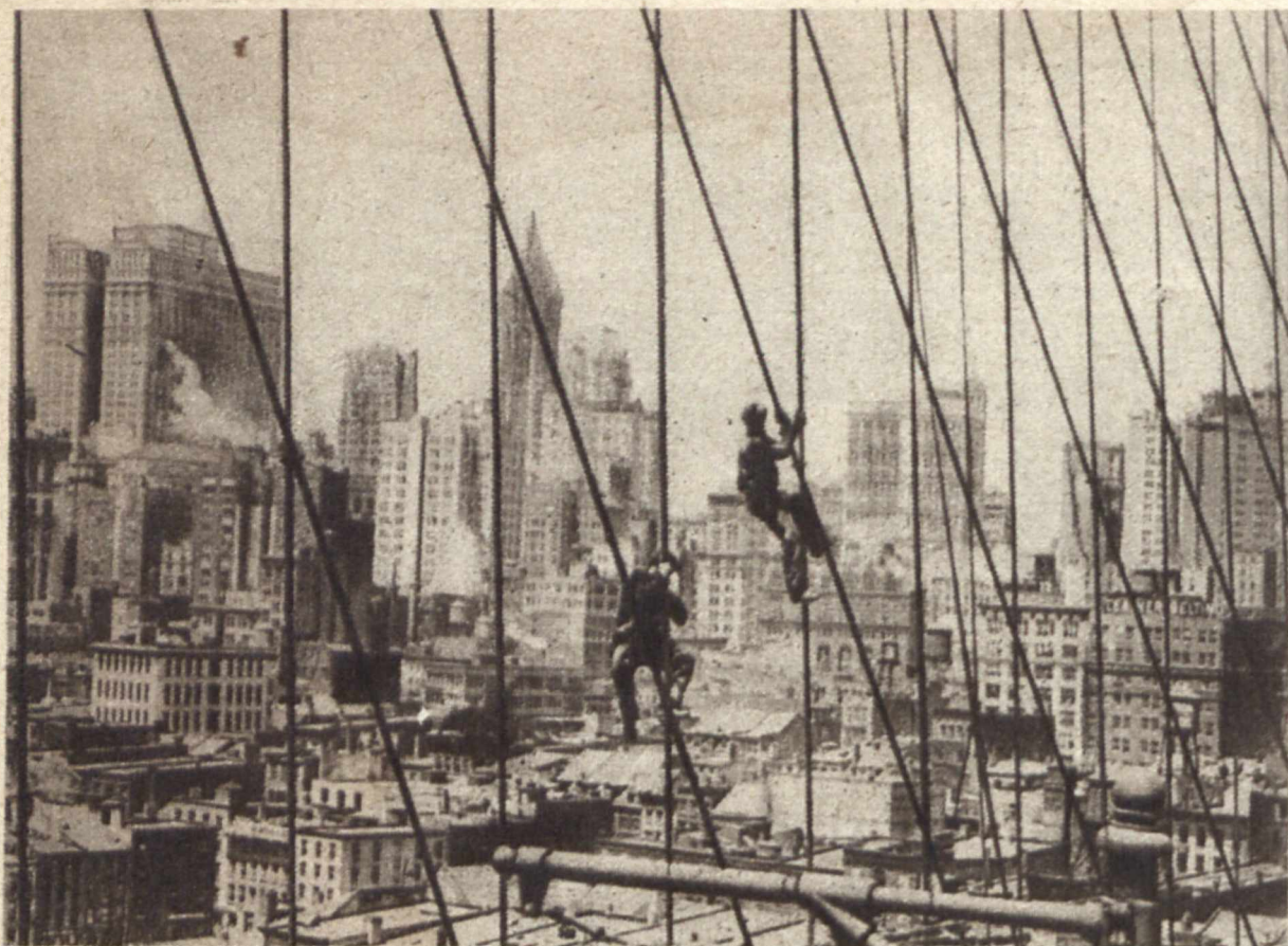
Nowa toaleta słynnego mostu. Olbrzymi most, łączący Brooklyn z właściwym Nowym Jorkiem poddano obecnie odnowieniu, przyczem przemalowywanie najwyższych części, a zwłaszcza sztab żelaznych, wysoko nad wodą wzniesionych, połączone jest niemal z niebezpieczeństwem.
